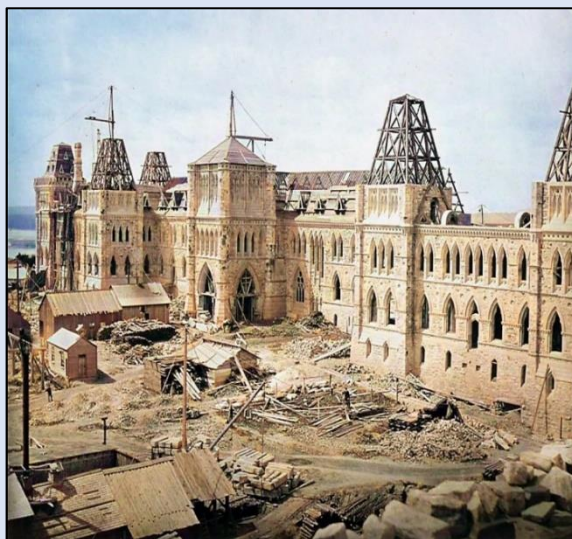
Figure 10. Construction du premier édifice parlementaire à Ottawa, début des années 1860. Source : Archives Canada.
